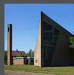
Waalwijk, 50 senioren appartementen met ontmoetingsruimte.
